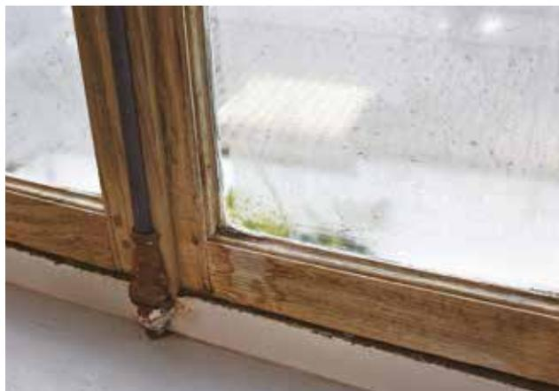
Si de la condensation apparaît sur vos fenêtres, c'est que la ventilation de votre logement est insuffisante.
