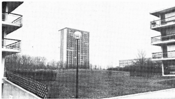
Au-delà de l'espace vert et avant la tour, 3,7 ha voués à la construction.
