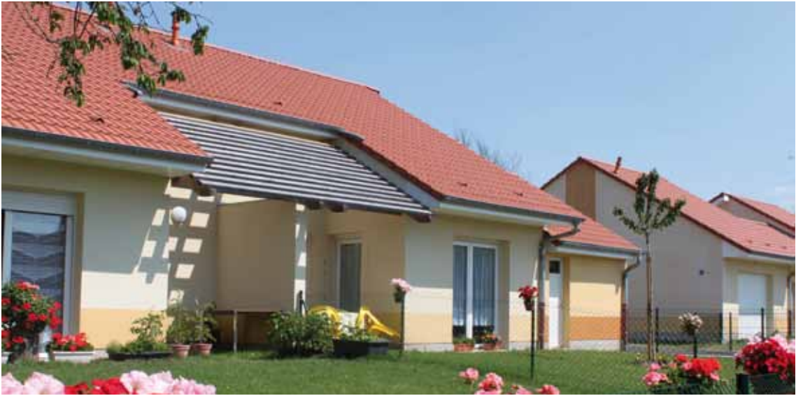
Clos du Verger à Faulquemont 2009
